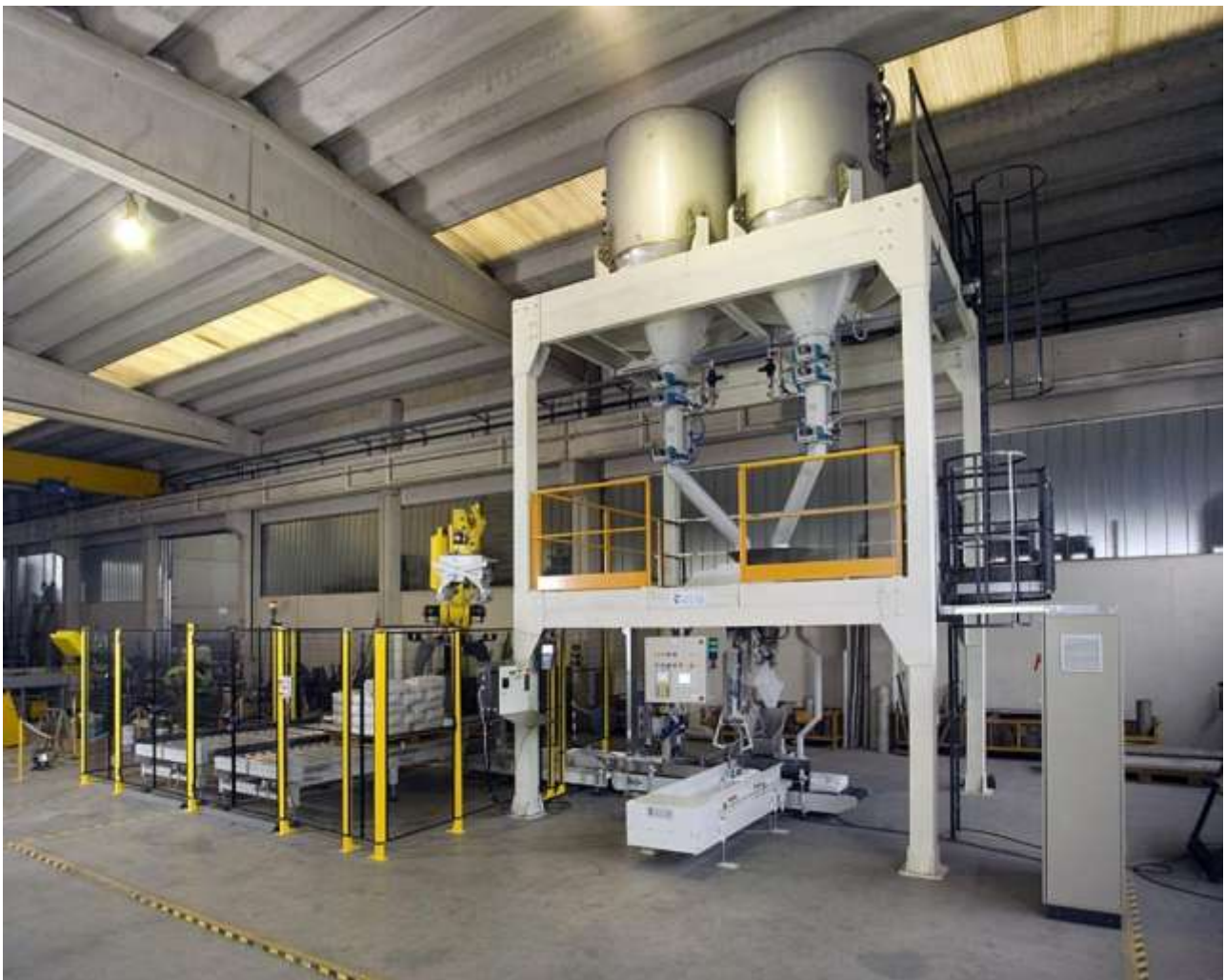
Impianto di fine linea
